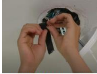
FIGURA (3) DEPOIS DE UNIDOS, PASSE A FITA ISSOLANTE INDIVIDUALMENTE EM CADA UM DOS FIOS QUE FICAREM. ESSE PASSO É MUITO IMPORTANTE: OS FIOS NÃO DEVEM SE ENCOSTAR PARA NÃO GERAR CURTO-CIRCUITO.
