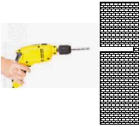
FIGURA (1) FAÇA A FURAÇÃO ONDE SERÁ FIXADO O PROJETO.
